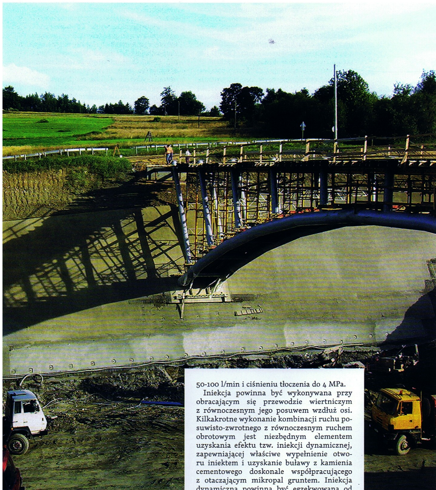
Ryc. 2 Posadowienie na mikropalach TITAN 73/53 obiektu mostowego nr 34 nad drogą ekspresową S69
