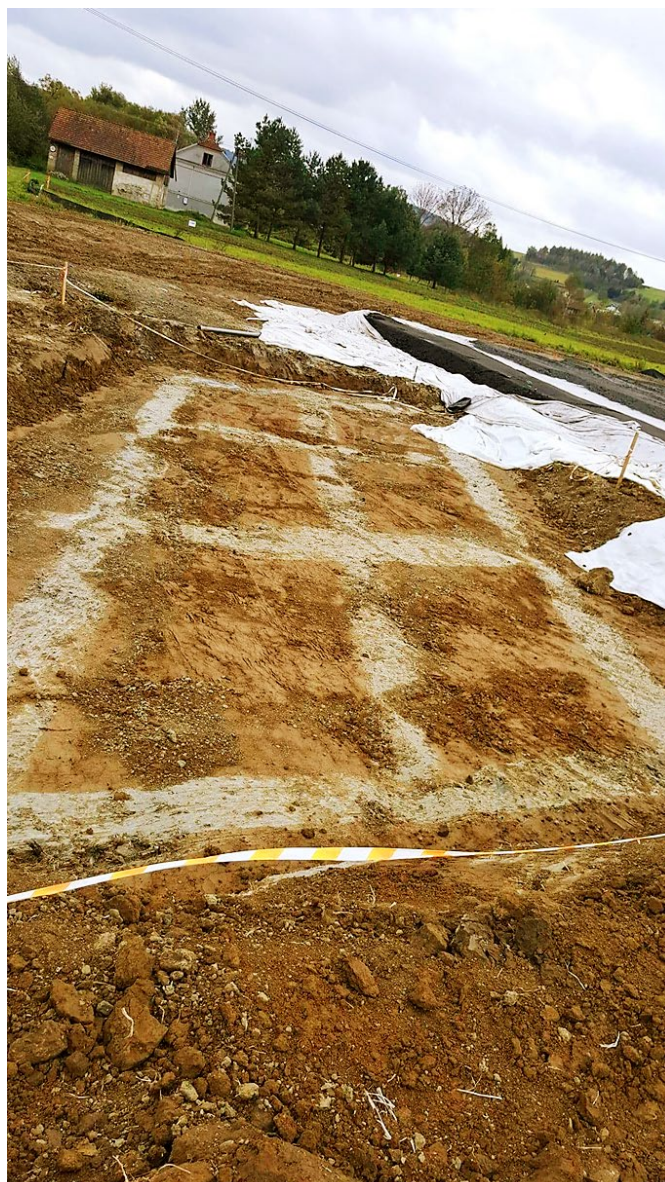
Ryc. 2. Odkryty ruszt w kształcie romboidalnej ramy wypełnionej żebrami w formie podwójnego krzyża
