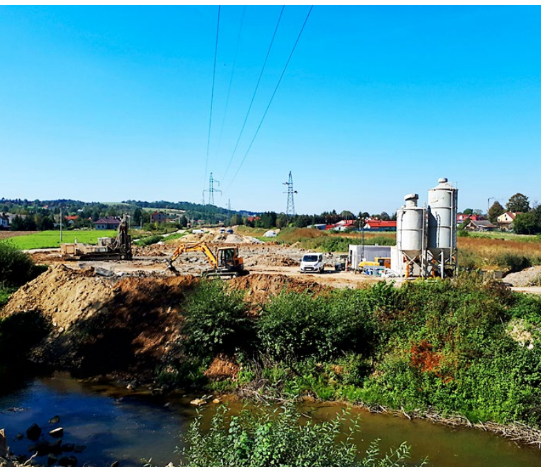
Ryc. 5. Bezpieczna praca pod czynną linią wysokiego napięcia
