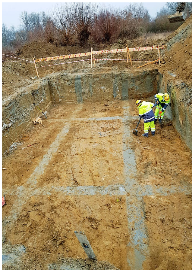
Ryc. 1. Widok odkrytego rusztu fibrogruntobetonu do zabezpieczenia wykopu z funkcją szalunku traconego dla robót żelbetowych przy wykonywaniu stóp fundamentów
